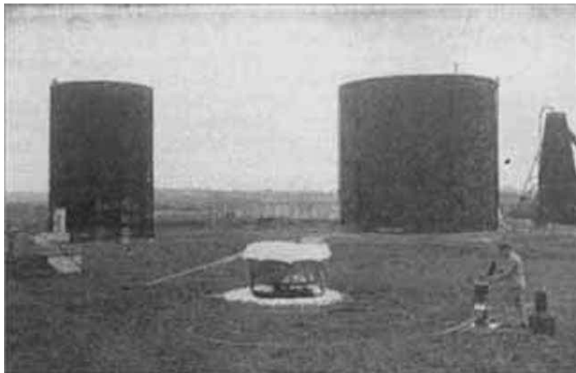
Abb. 4. Schaumerzeugung aus dem Generator der Minimax-A.-G.
